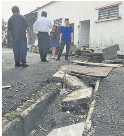
基于史里肯邦安中小型工业区常有罗里出入，导致曾在 2 年前修复的沟渠盖再次坍塌而破损。
